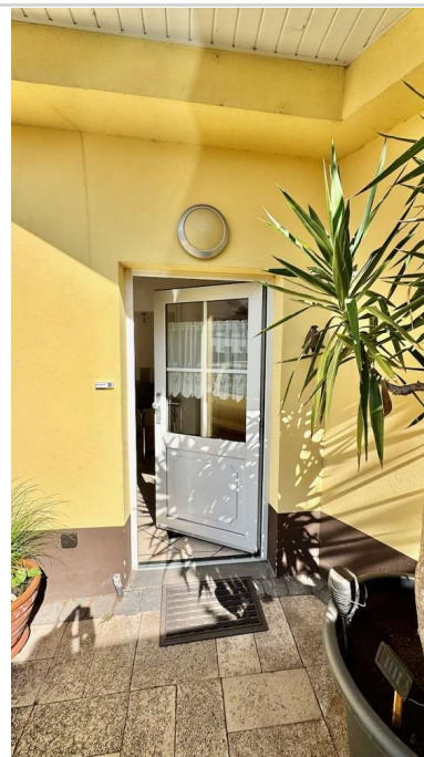
EG Eingang Blick 2
